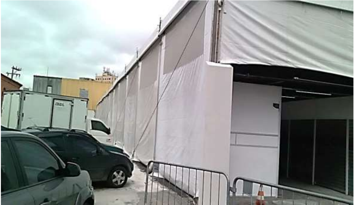
Vista da parte lateral esquerda da “tenda” em finalização.
