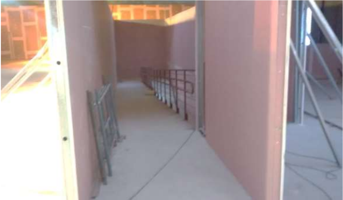
Vista de rampa de acesso ao piso superior da edificação.
