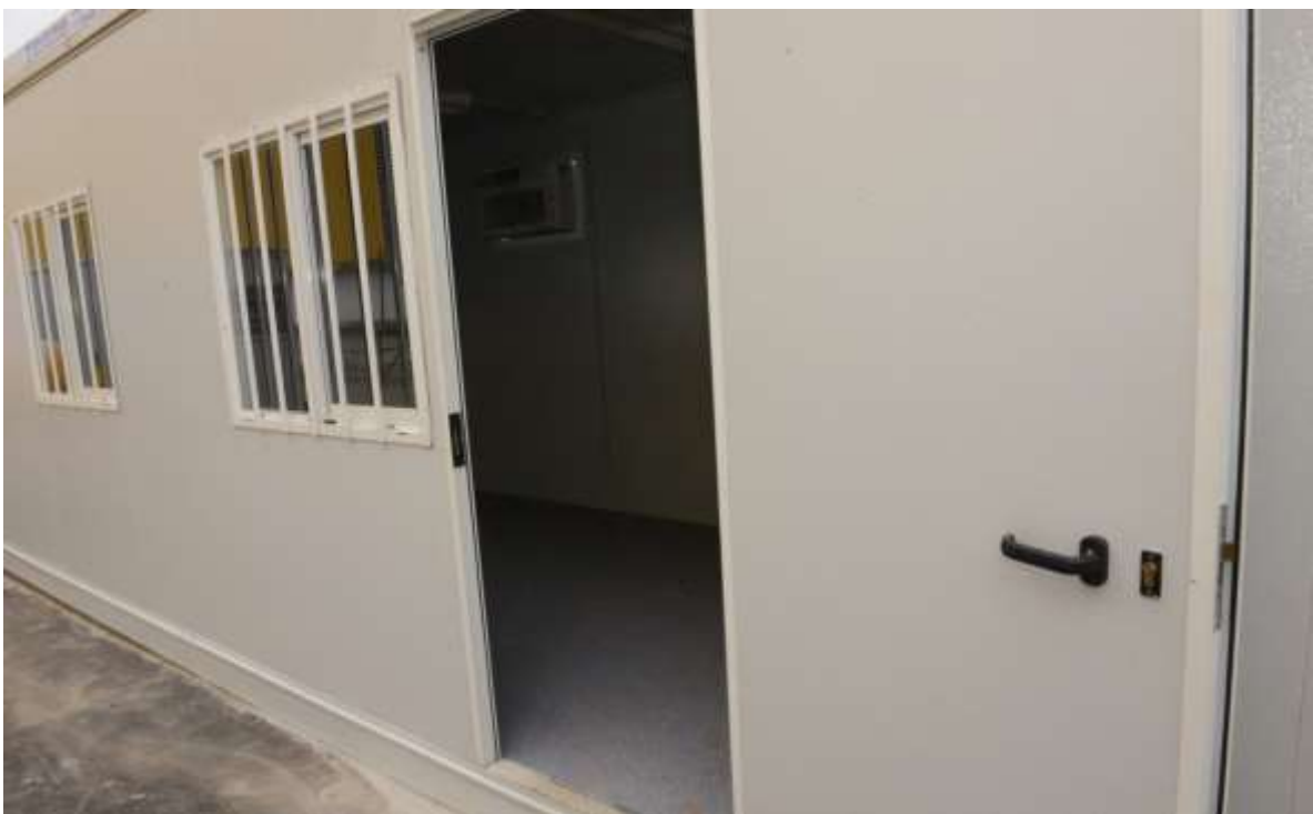
Vista dos containers para escritórios.
