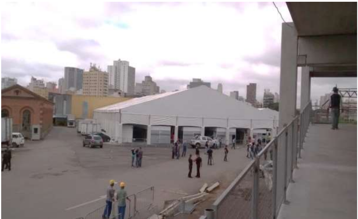
Vista frontal da “tenda” em finalização de obras.
