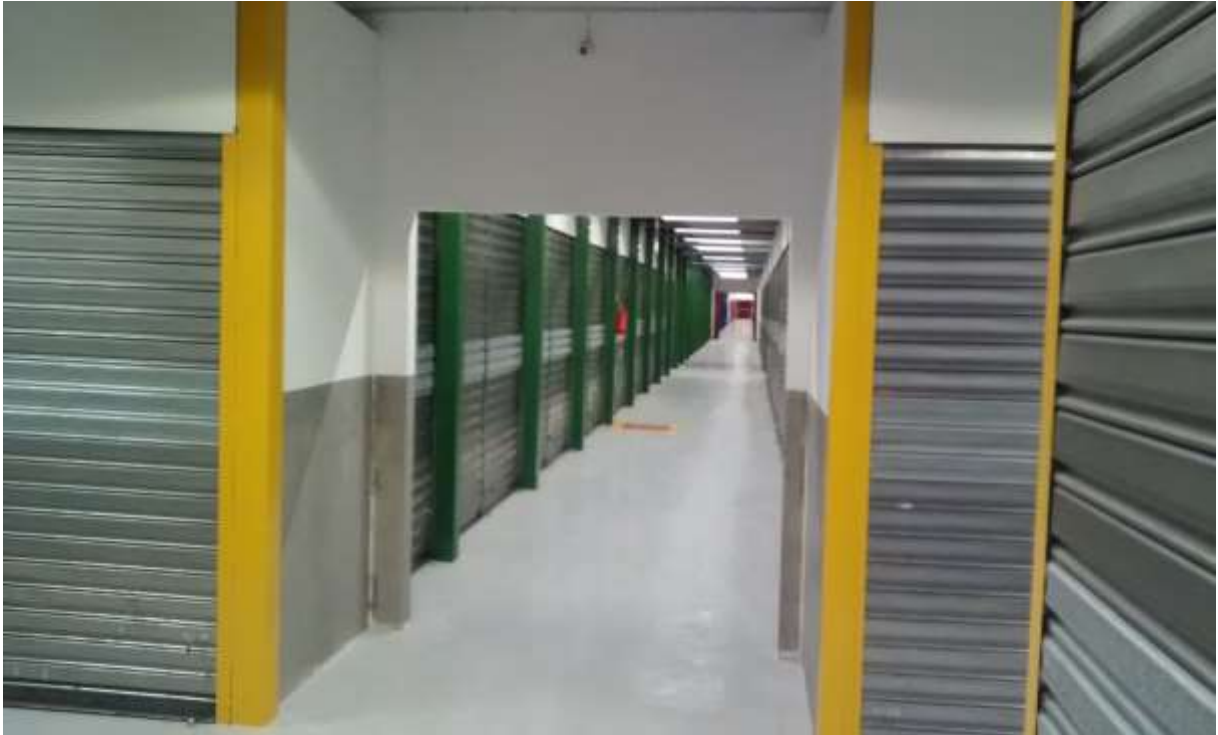
Vista de passagem entre setores no piso térreo.
