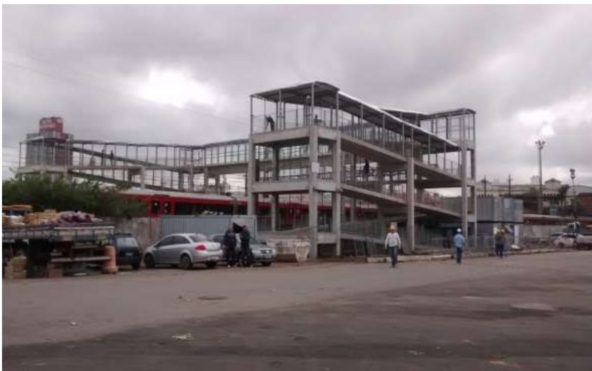
Passarela em 23/11/2017, do lado do Amarelão.
