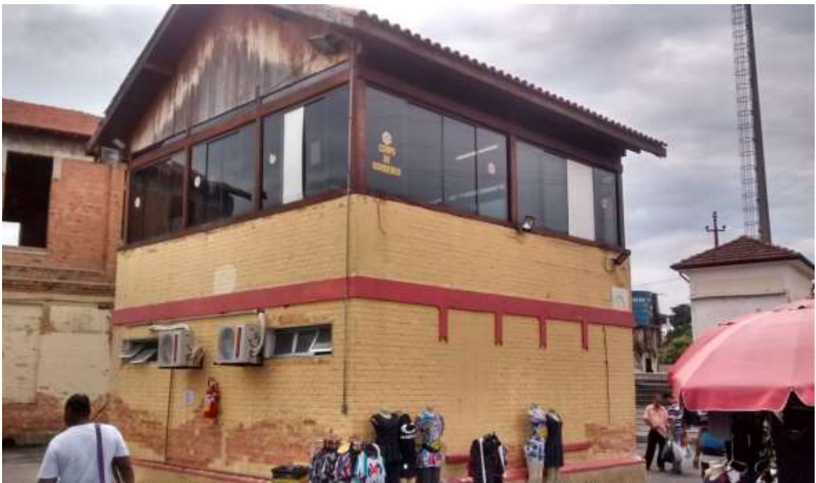
Vista do posto de bombeiros na feira da madrugada, em novembro de 2017.
