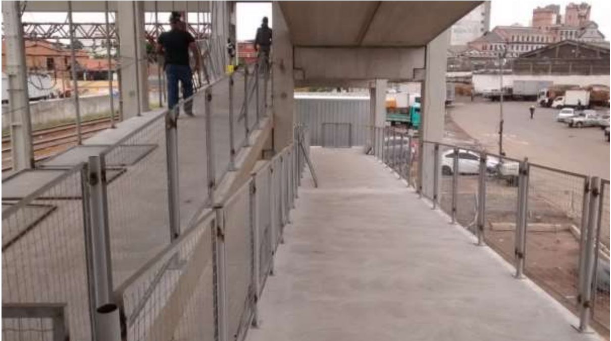
Rampa de acesso para a passarela em 23/11/2017, do lado do Amarelão.
