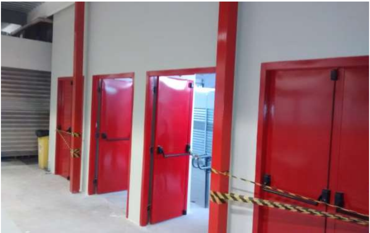
Vista de portas corta-fogo na passagem da “tenda” para a área interna da edificação.
