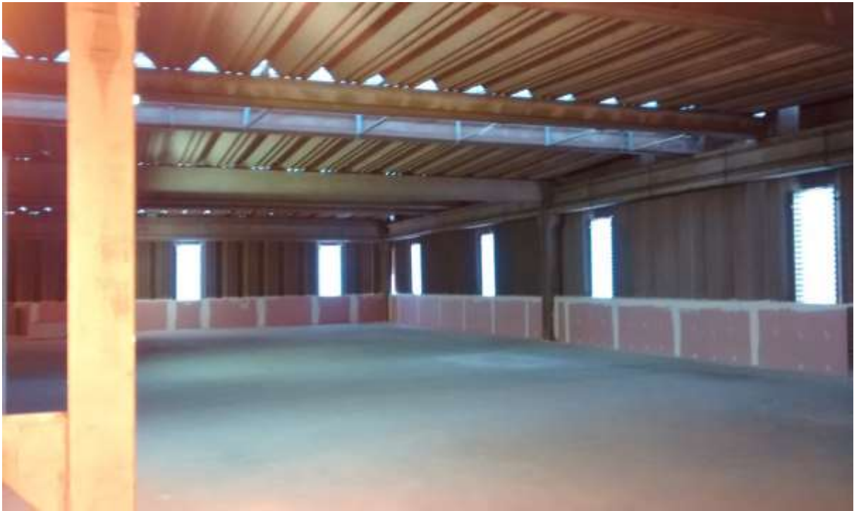
Vista do espaço onde serão colocados boxes no piso superior da edificação.
