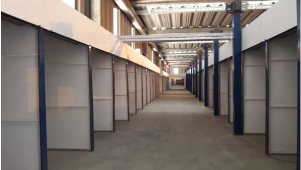
Vistas dos boxes em obras.
