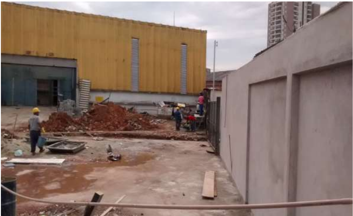
Vista da entrada do Amarelão pela Avenida do Estado, obras no muro de divisa com Hortifruti em finalização.
