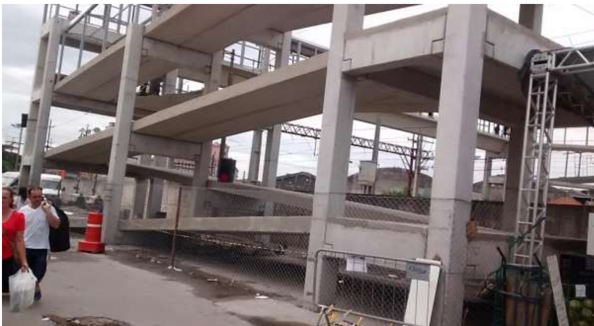
Rampa de acesso à passarela em 23/11/2017, do lado da Feira da Madrugada.
