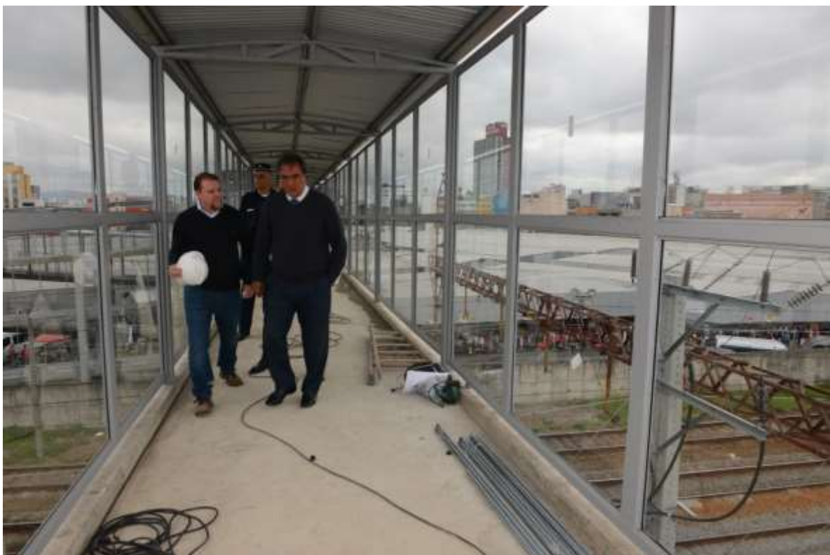
Passarela em finalização de obras, 23/11/17.
