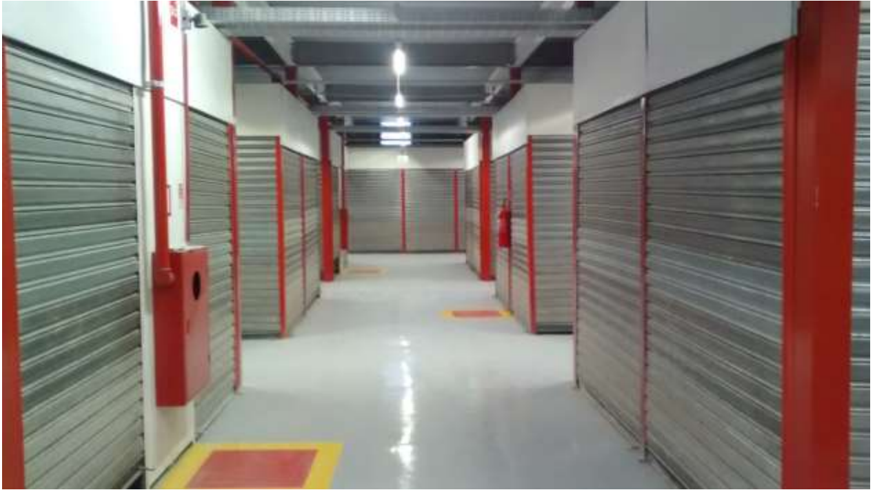
Vista dos boxes provisórios no piso térreo.
