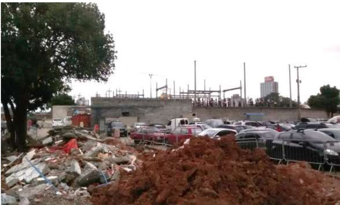
Obras na área defronte a Avenida do Estado.
