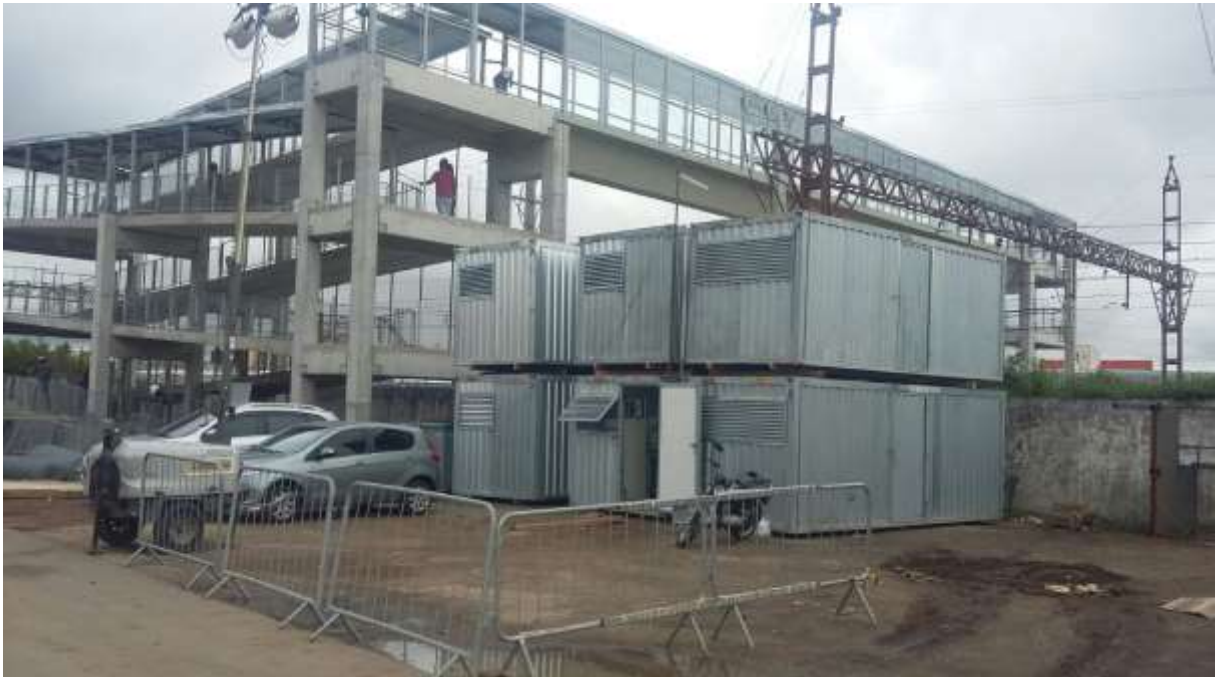
Passarela em 23/11/2017, do lado do Amarelão.
