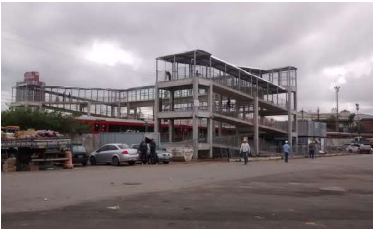
Passarela em 23/11/2017, do lado do Amarelão.
