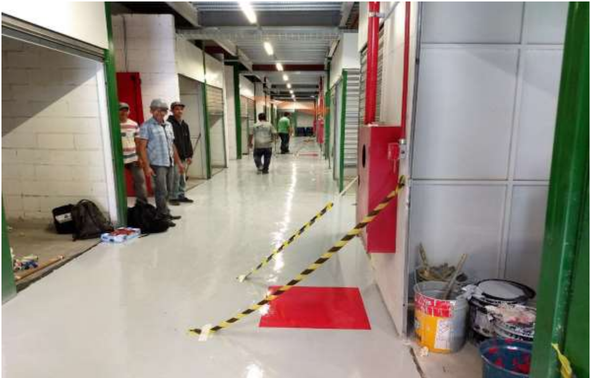
Vista de hidrante e extintores sinalizados no piso térreo.
