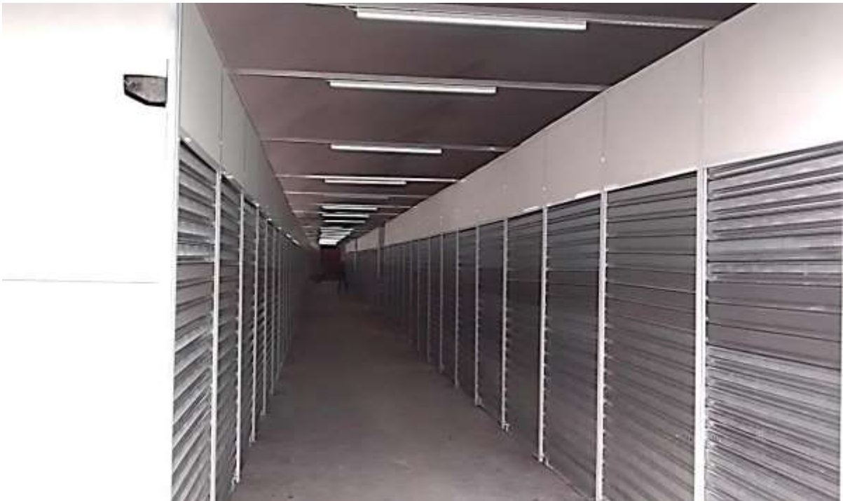
Vista de corredor com boxes em finalização na “tenda”.
