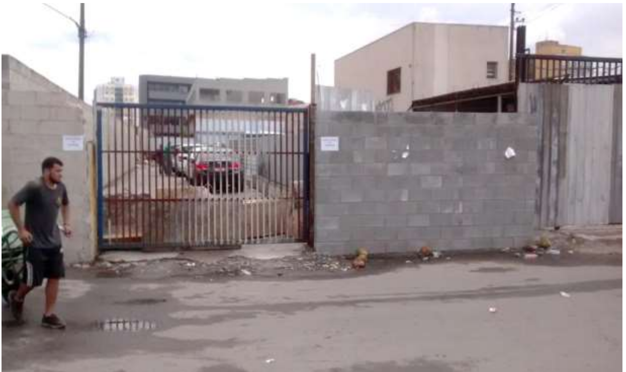
Vista da área do antigo posto de abastecimento, em novembro de 2017.
