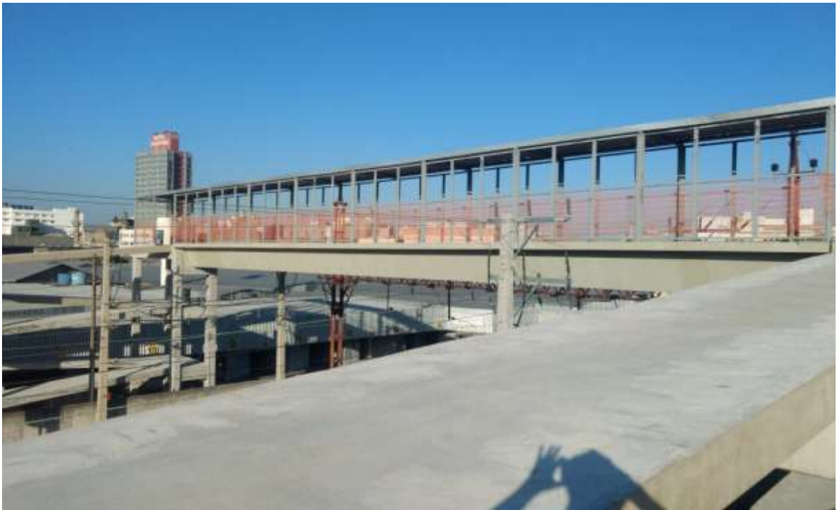
Vista da passarela em 13/11/2017
