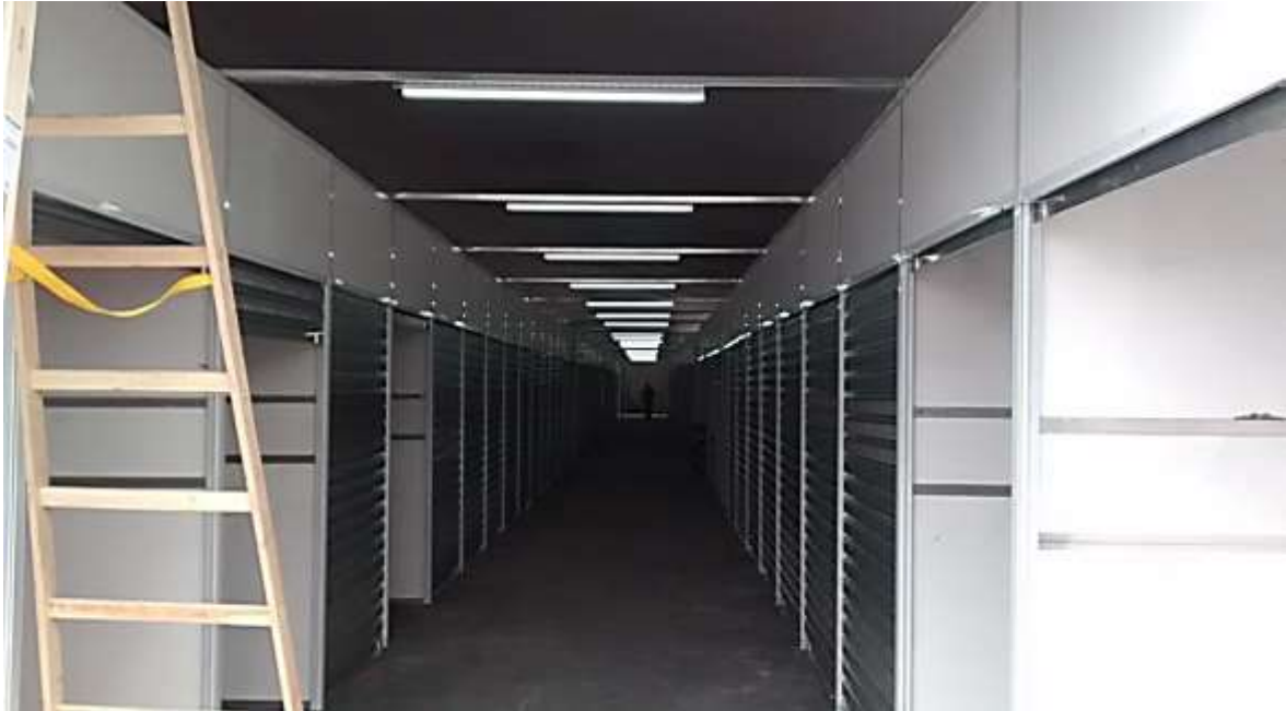
Vista de corredor com boxes em finalização na “tenda”.
