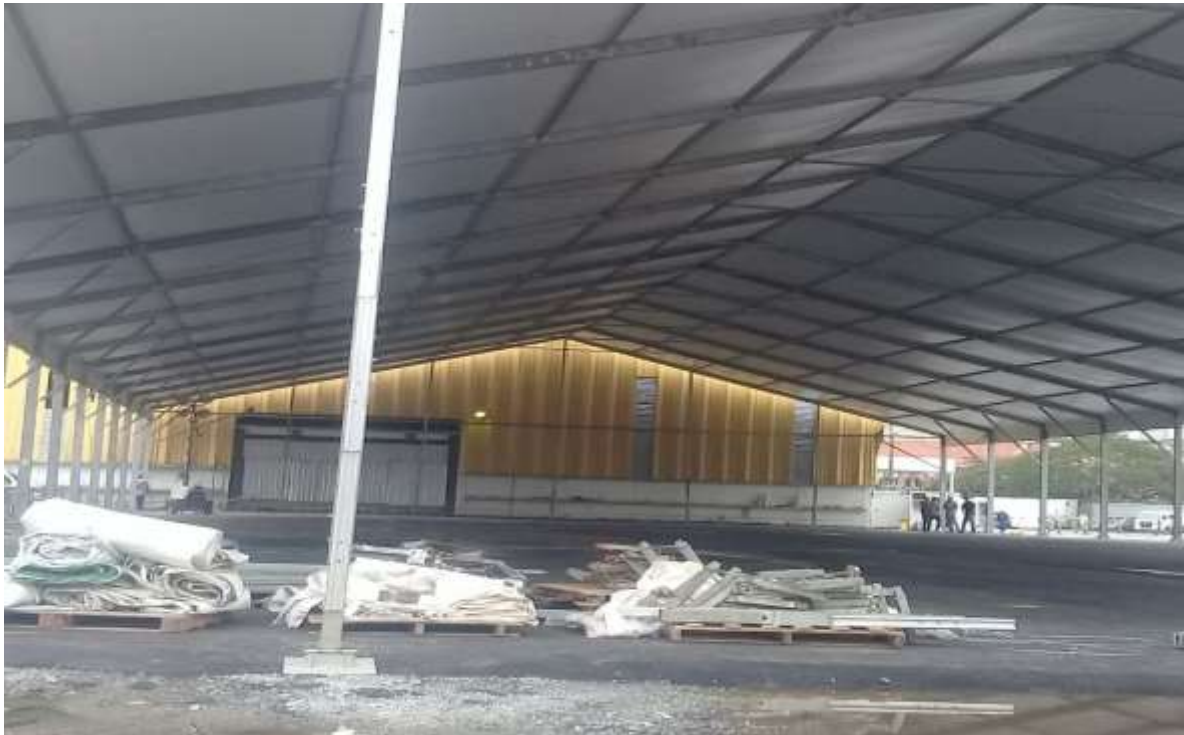
Tenda em obras em 06/11/2017
