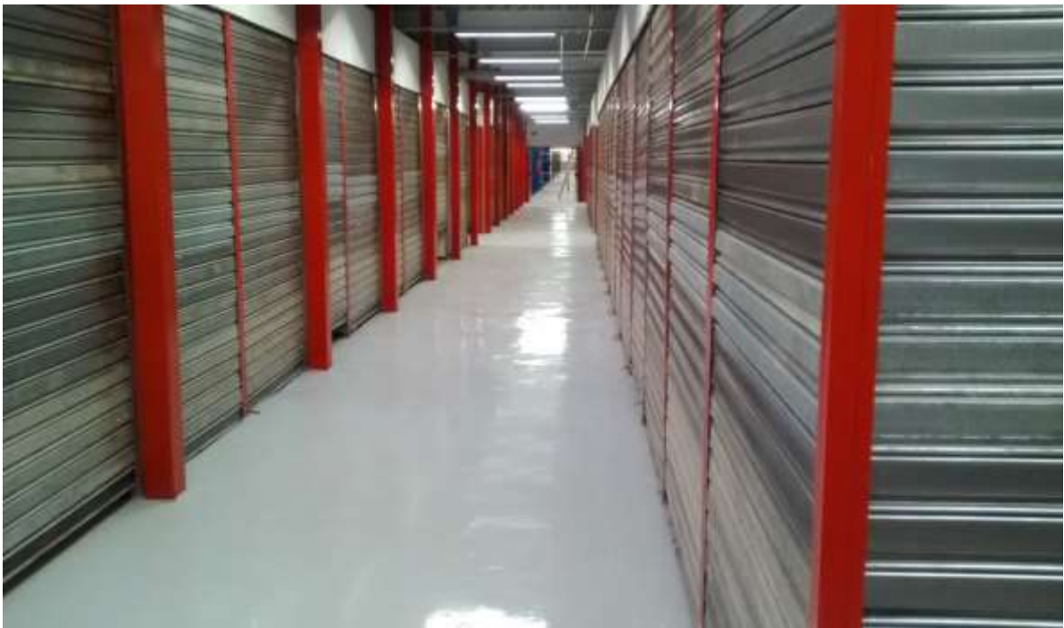
Vista de boxes finalizados no piso térreo.
