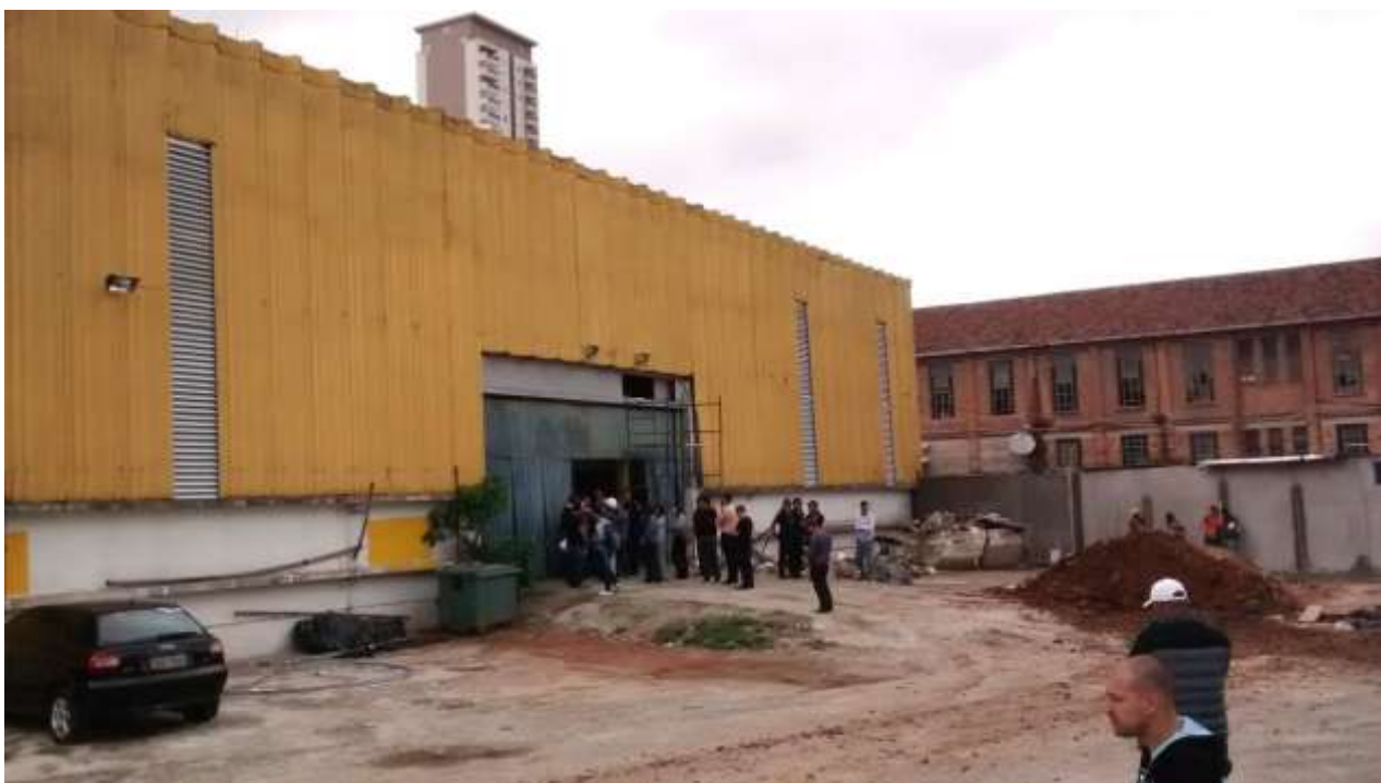
Vista da área da entrada da edificação defronte a Avenida do Estado.
