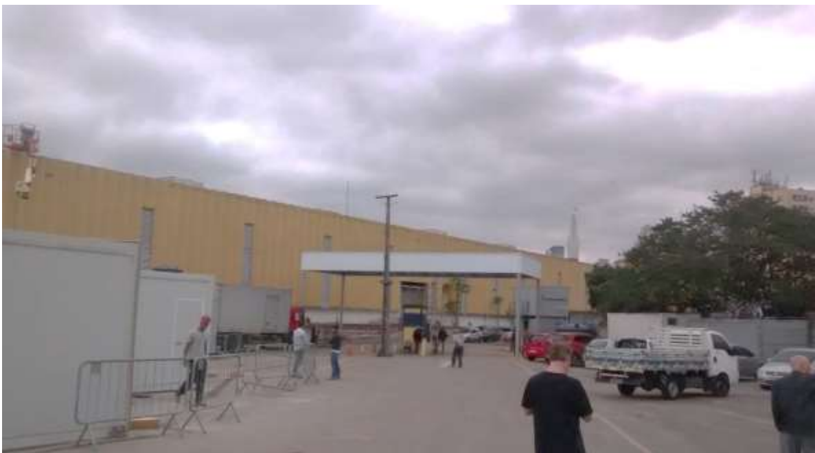
Vista de acesso ao estacionamento na lateral da edificação.
