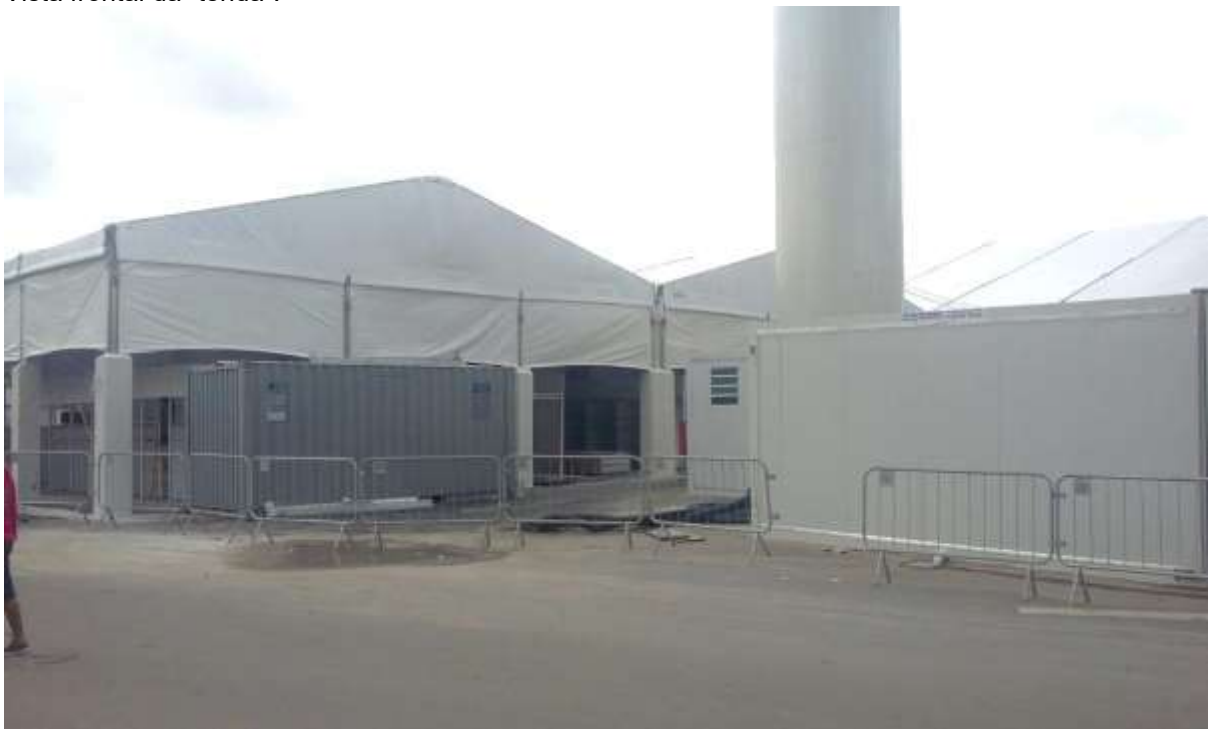
Vista da área de fundos da “tenda” em finalização e containers.
