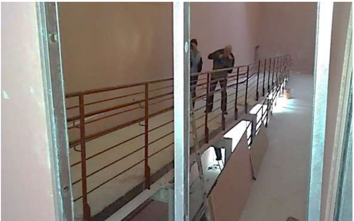
Vista de rampa de acesso ao piso superior da edificação.
