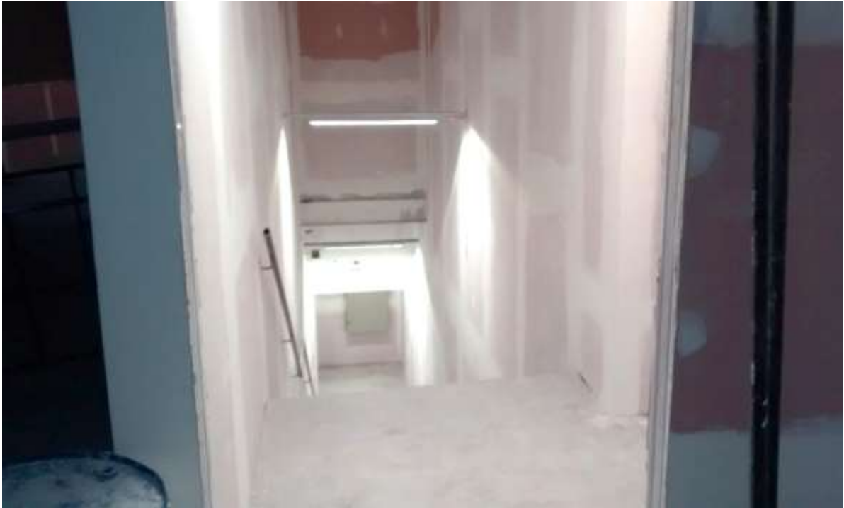
Vista de escada de acesso ao piso superior em finalização das obras.
