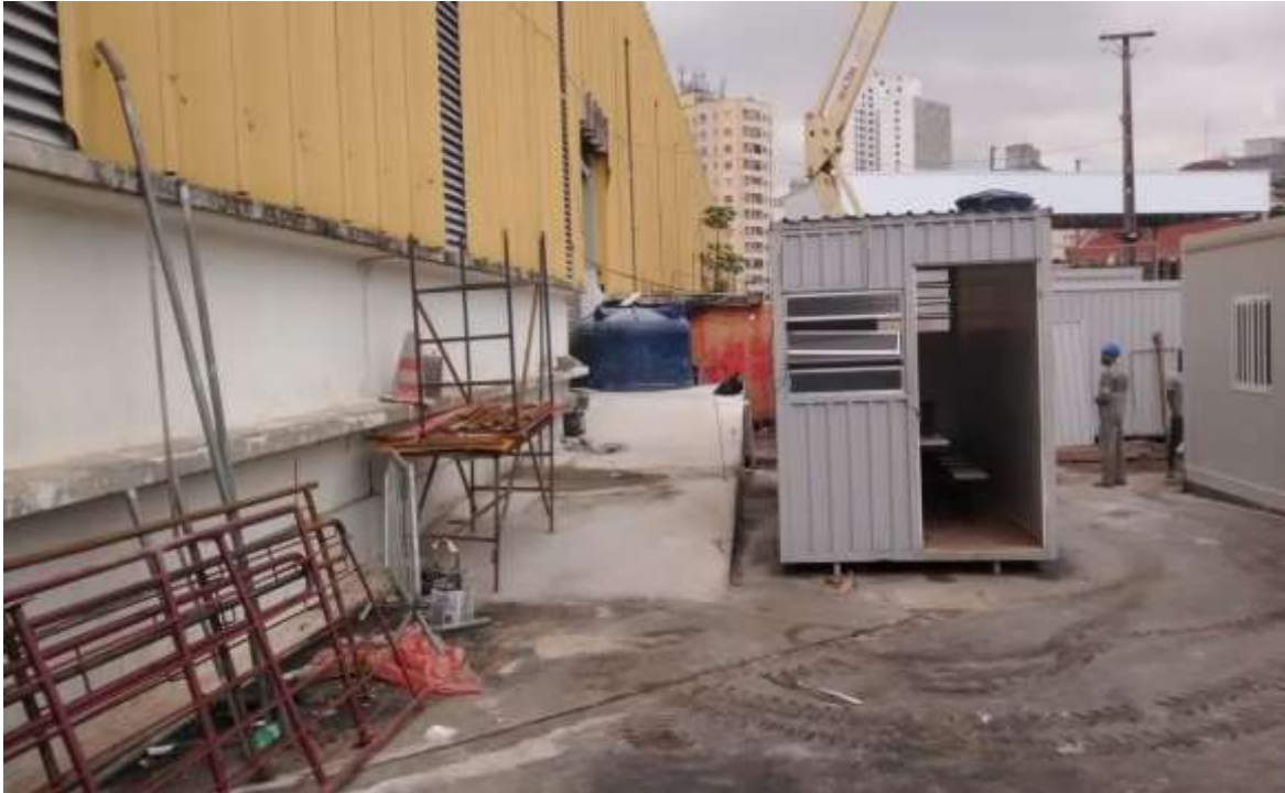
Vista rampa de acesso lateral para a edificação.
