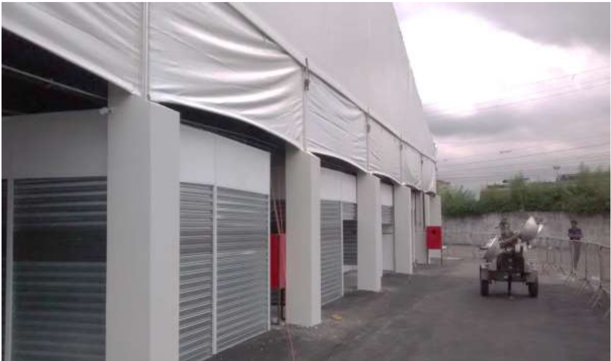
Vista de boxes na lateral direita da “tenda”, em finalização.
