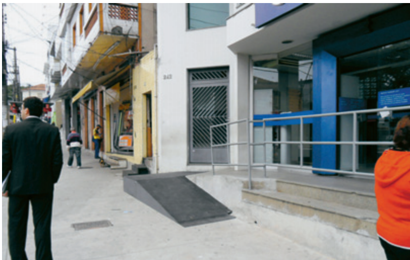
Foto 03: Vista do acesso precário e inseguro a uma agência bancária do município
