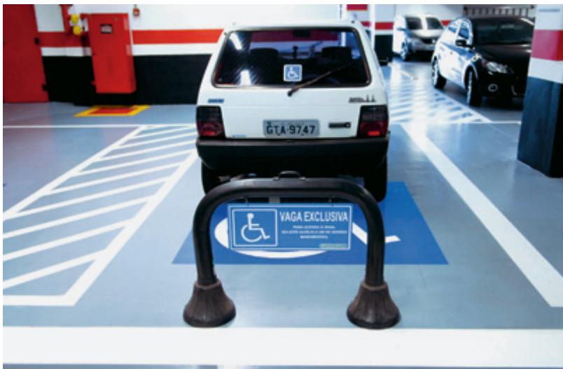
Foto 01: Vista de uma vaga de estacionamento reservada para veículos de pessoas com deficiência e mobilidade reduzida e com cavalete impeditivo de utilização por outros veículos
