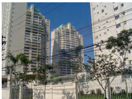
Foto 5 – Condomínio residencial na Mooca, implantado em antiga área industrial
