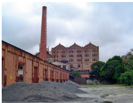
Foto 1 - Antiga indústria metalúrgica ocupada por sem-tetos na Mooca
