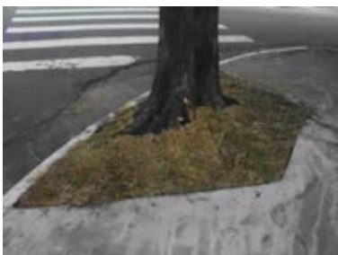
Fig.19 - Certo: Ampliação de canteiros, evitando-se o corte de raízes
