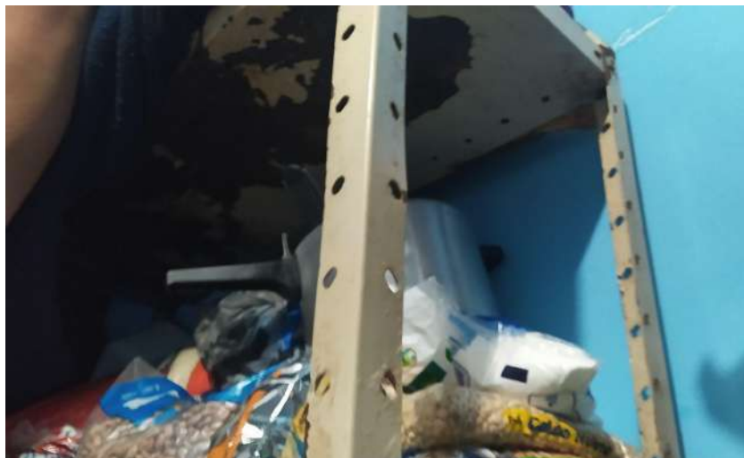
Figura 6: detalhe de estante enferrujada
