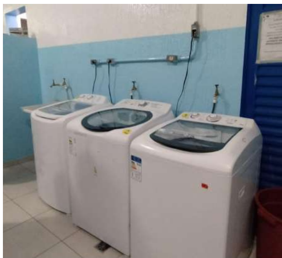
Figura 15: máquinas de lavar
