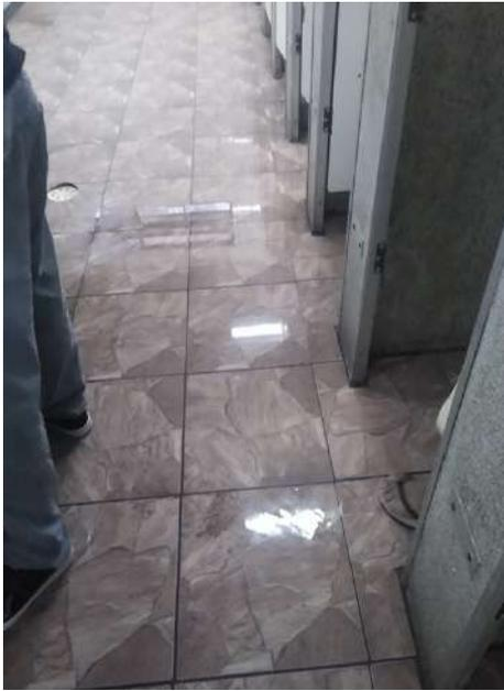
Figura 10: chão molhado com a água do sanitário
