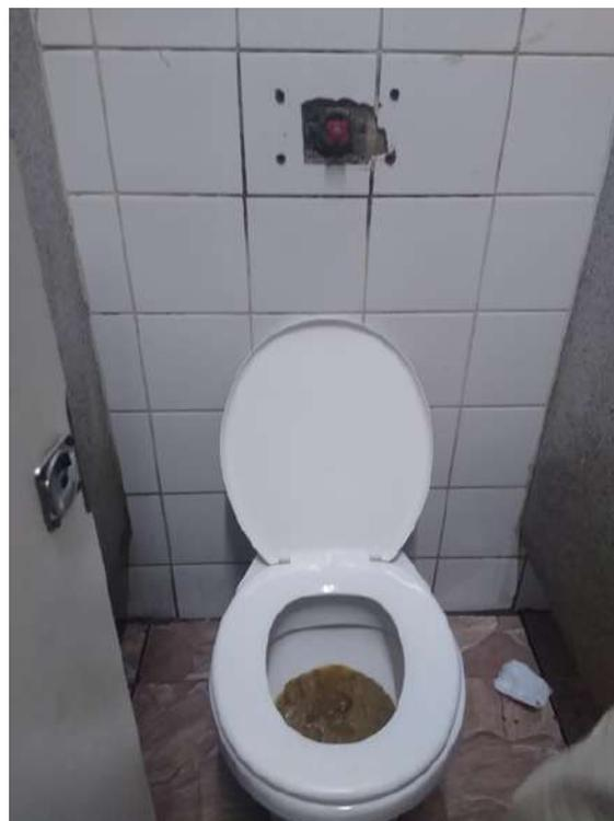
Figura 9: sanitário entupido e espelho quebrado
