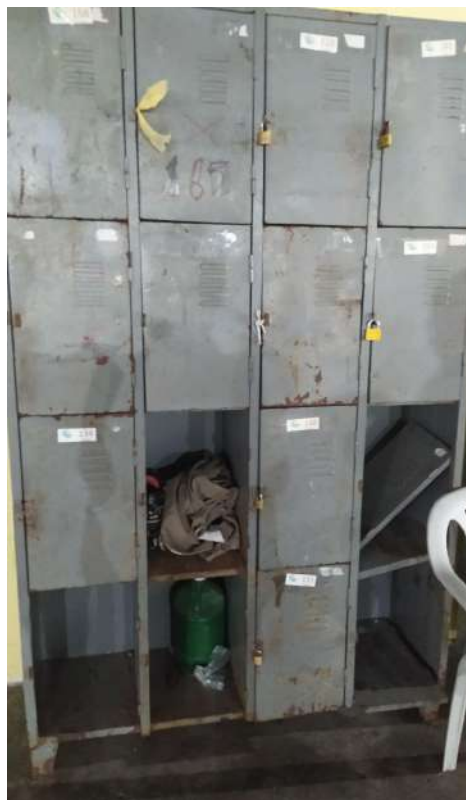
Figura 14: detalhe do armário pequeno, sem porta e enferrujado
