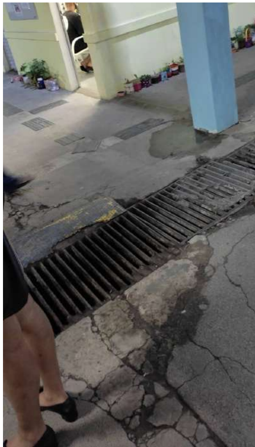
Figura 3: vala de esgoto aberta no pátio
