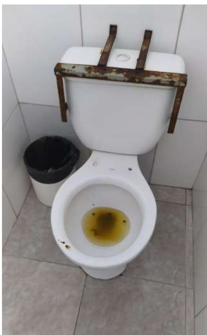
Figura 11: privada entupida e sem assento (banheiro feminino)
