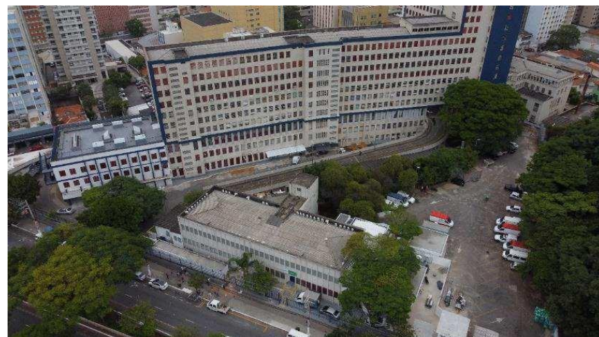
Reforma do PS do HSPM (concluído) Equipamentos (concluído)
