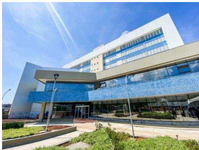
Construção do Hospital de Brasília (concluído) Equipamentos (concluído)
