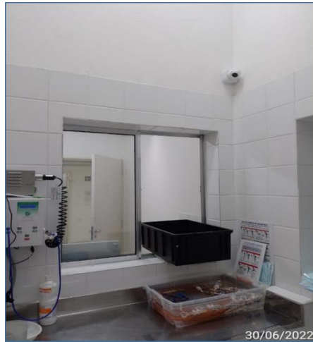
Aplicação de azulejo, preparo e pintura das paredes
