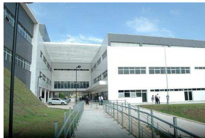
Equipamentos Hospital de Parelheiros - Hosp Mun Josanias Castanha Braga (concluído)
