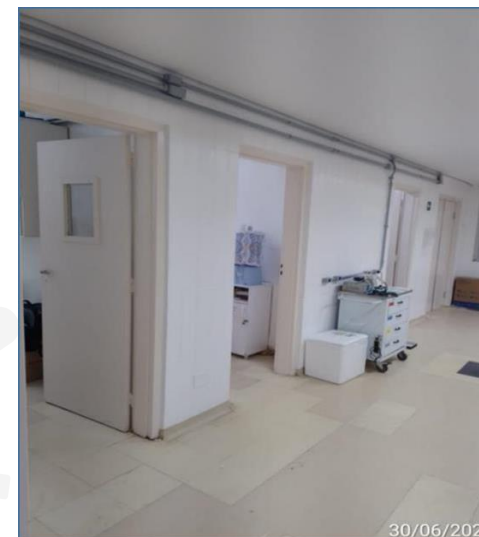
Preparo e pintura das paredes, portas e batentes. Substituições dos pisos vinílicos danificados.
