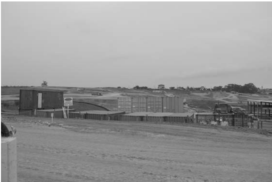
Foto 03 - Instalações do canteiro de obras ao fundo. (Foto: Assessoria Vereadores)
