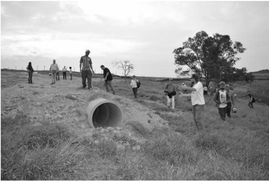
Foto 11 - Tubulação instalada pela construtora com saída para a área de parque, ao fundo cerca de limite entre a obra e o parque. (Foto: Assessoria Vereadores)
