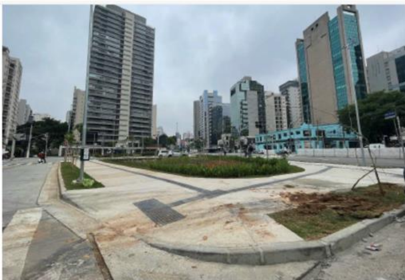
Figura 3 Vista da praça em questão, a partir da Rua Egito, esquina com a rua Dona Maria Augusta Saraiva
