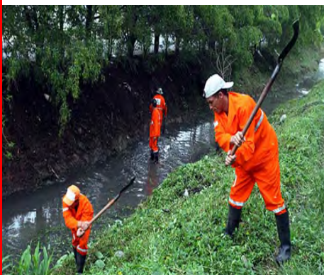
Limpeza de Córrego
