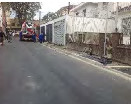
Rua Atuaú Remodelada
