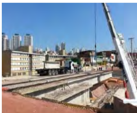
Obra de Viaduto na Av. Perimetral Paraisópolis
