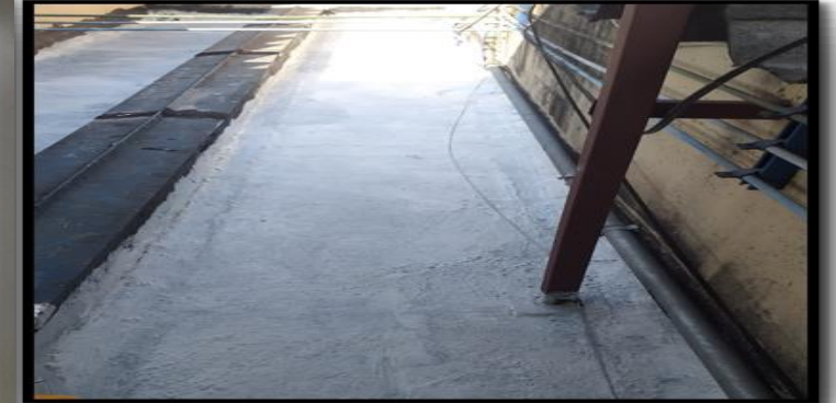
Impermeabilização Telhado
