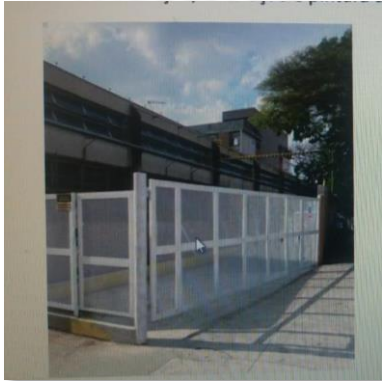
Confecção, Instalação e Pintura de Portão
