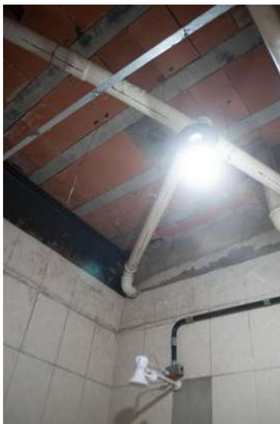
Figura 10: banheiro no térreo, sem forro
