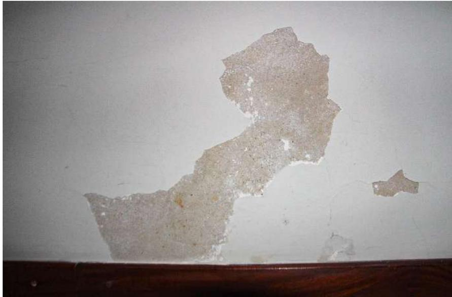
Figura 3: parede descascando
