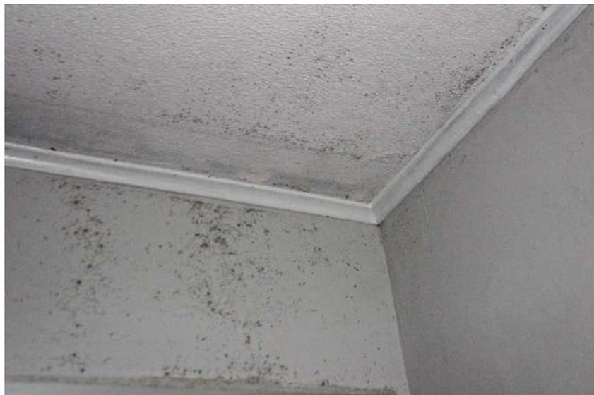
Figura 1: marcas de mofo na parede e no teto do quarto
